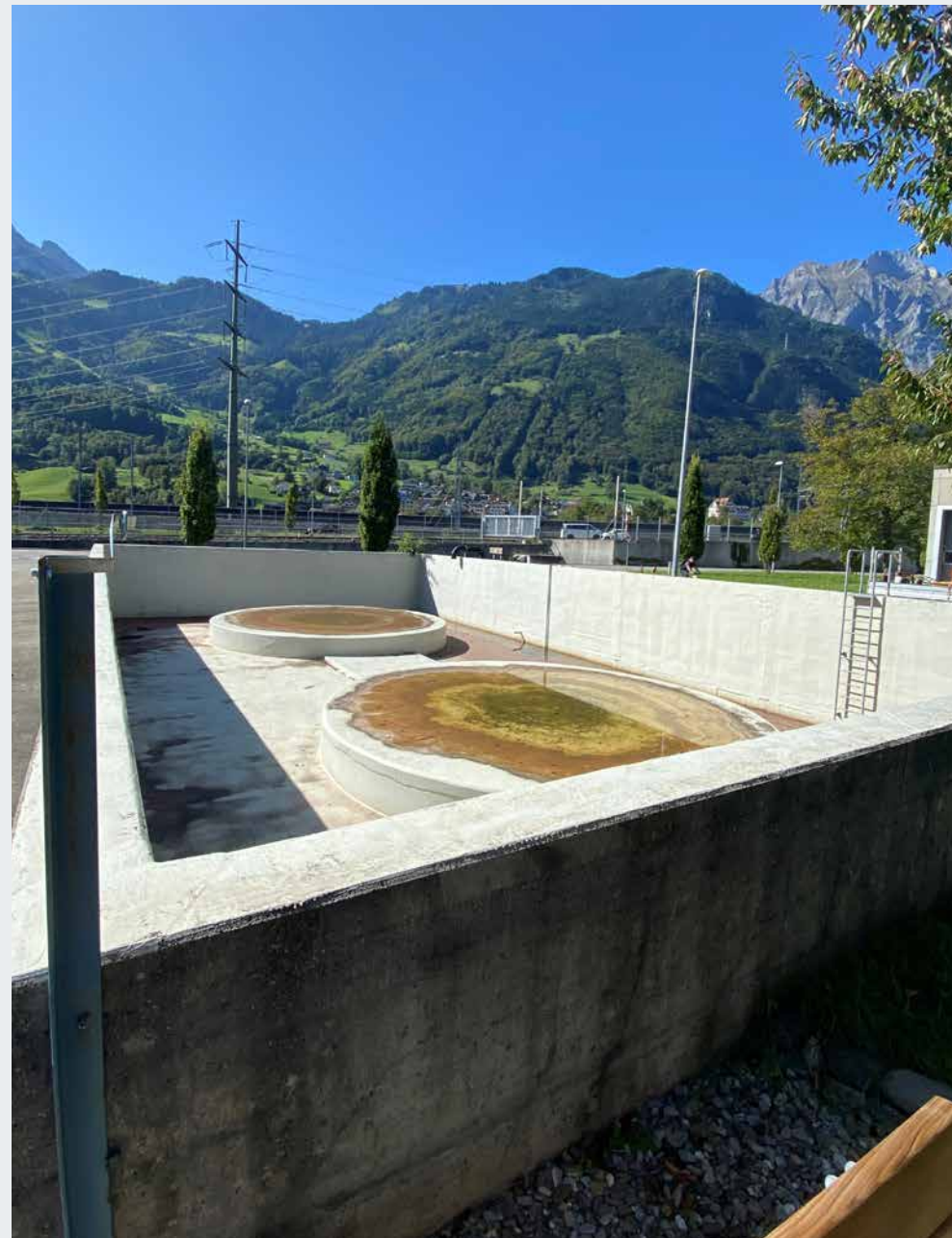
Rückhaltebecken RUAG-Areal Altdorf
