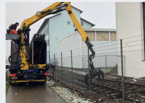
Zubringer-Gleisanlage weicht einer ökologischen Ausgleichsfläche.
